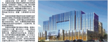
格鲁吉亚青奥村酒店项目顺利开工
