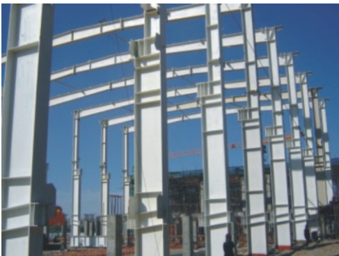
霍煤鸿骏铝合金三车间和电解四车间（中国钢结构金奖）
