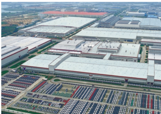
奇瑞汽车大连分公司冲焊联合厂房钢结构工程（浙江省“金刚奖”）
