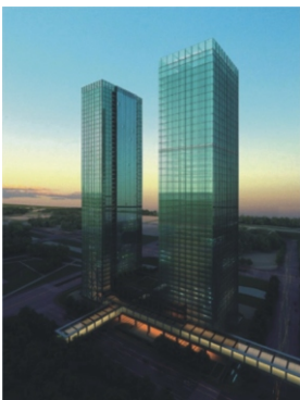
万银双子中心钢结构工程（中国钢结构金奖）
