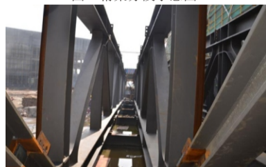
图8 桁架拼装完成图
