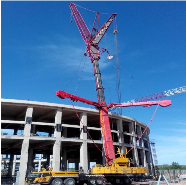
▲350吨汽车吊调试工作
