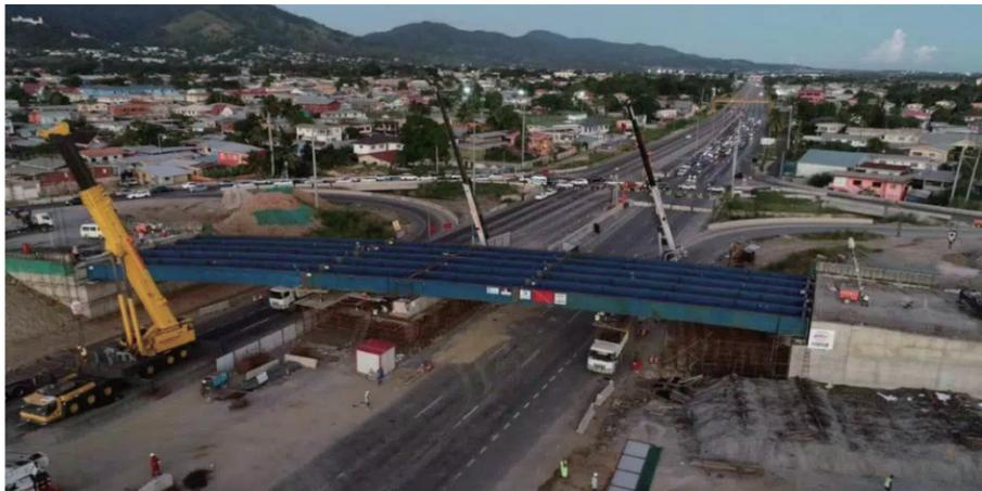
为6片截面为H1600\*400\*16\*60 H型钢梁，通过支撑相互连接，使用材料为美标耐腐蚀钢材 ASTM GR50W 材质，完全按照美国钢结构协会的标准（AASHTO AWS D1.5M D1.5-2015）要求加工与验收。
