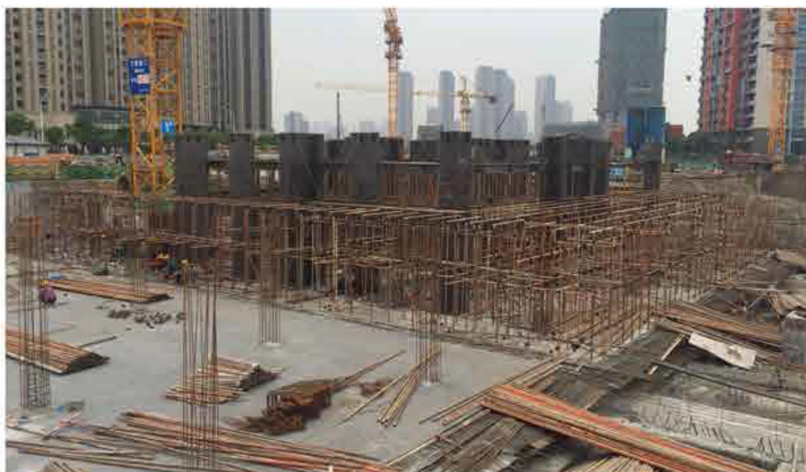
绿城九龙仓·柳岸晓风施工现场
