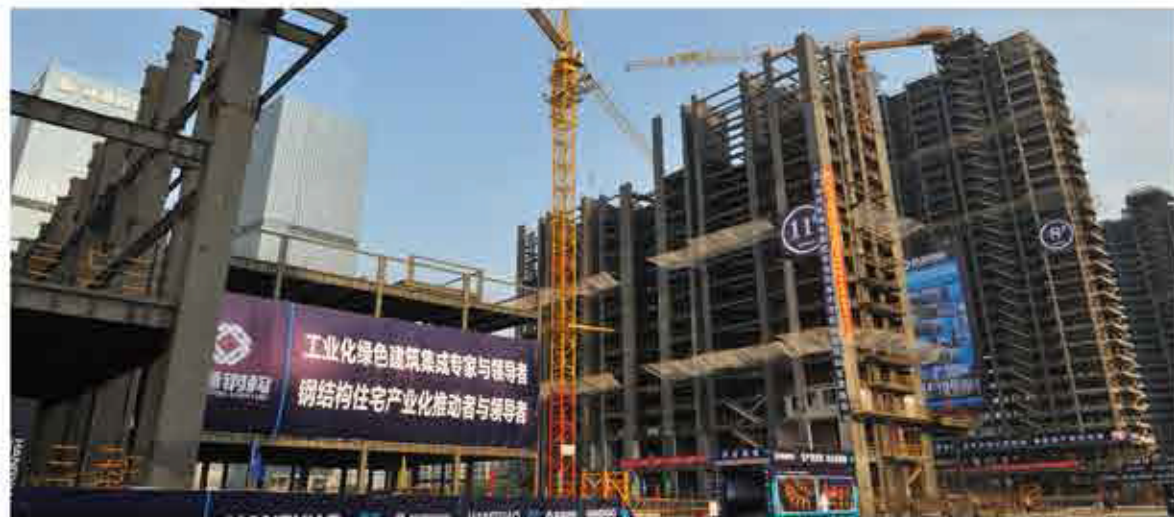
杭萧钢构钱江世纪城人才专项用房
