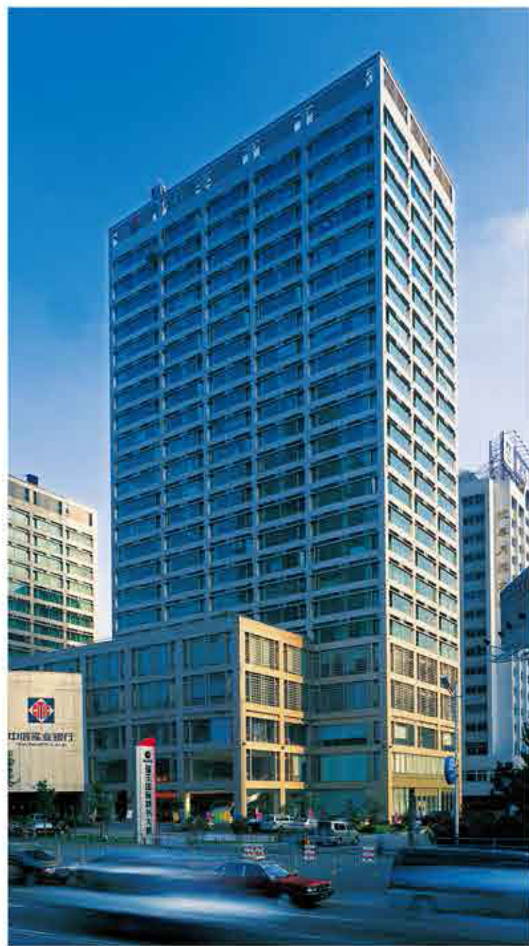
杭萧总部 瑞丰大厦
