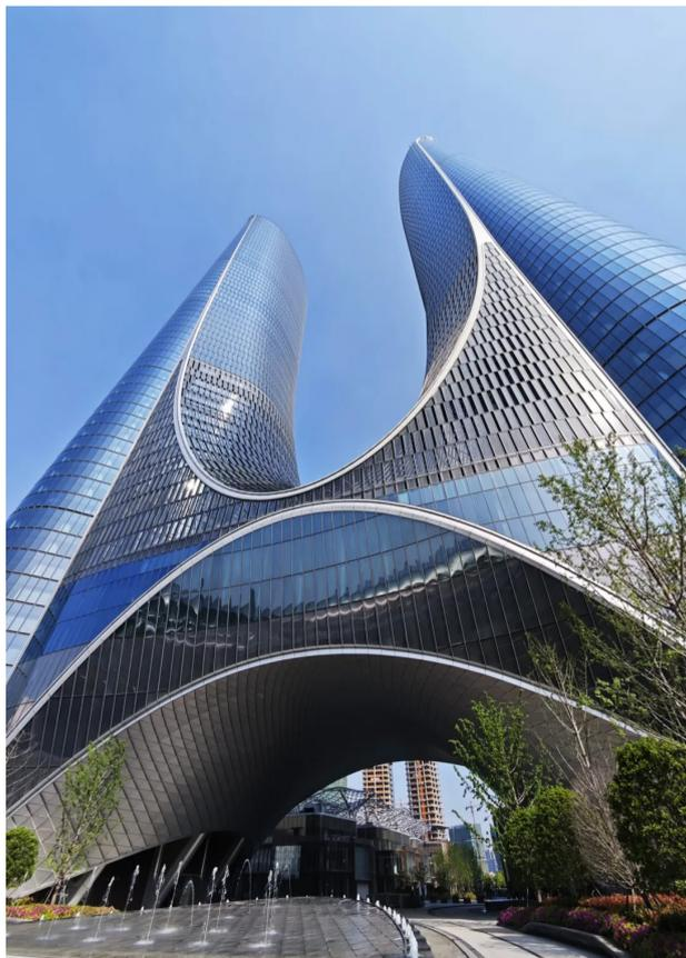
被市民叫做“杭州之门”的世纪中心，是杭州城市新地标。这个以“H”为外形的“双子塔”，主塔楼建筑高度310米，为杭州市已建成的最高建筑，其最大特色是以钢连桥相连，中部为马鞍型双曲悬垂屋面，最大跨度85米。如何在悬空之中实现钢连桥长期平稳不下沉？这是最大难点。
